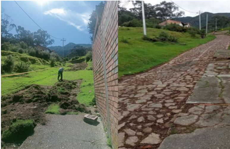
Imagen 40 y 41: Avance de la intervención y recuperación del espacio del Parque la Peña.
