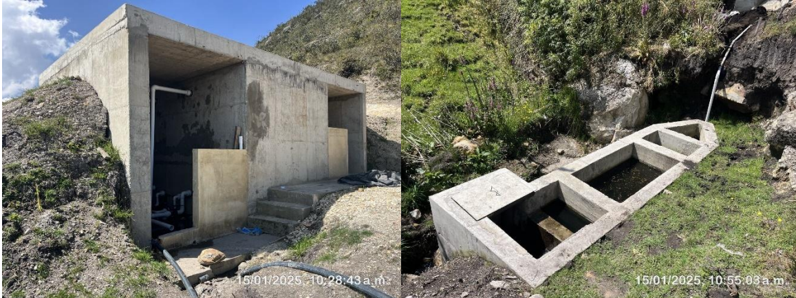
Imagen 33 y 34 Avances del proyecto de acueducto veredal – Visita realizada 15/enero/2025
