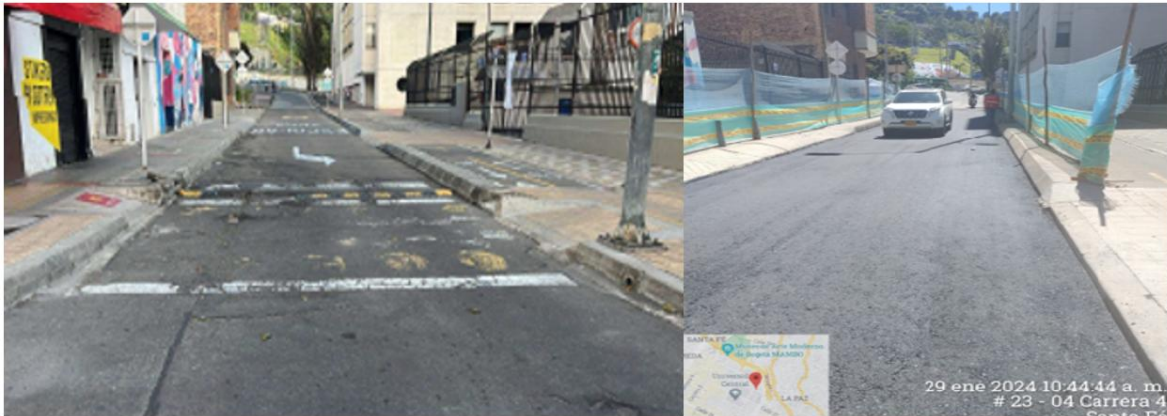
Imagen 44. Antes y después ejecución de las obras de la malla vial urbana (Calle 23 #4)
