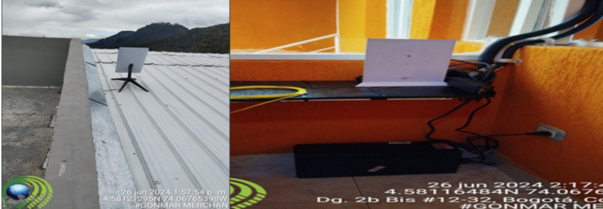
Imagen 45: Instalación de la antena, Router y UPS operando SC San Dionisio)
